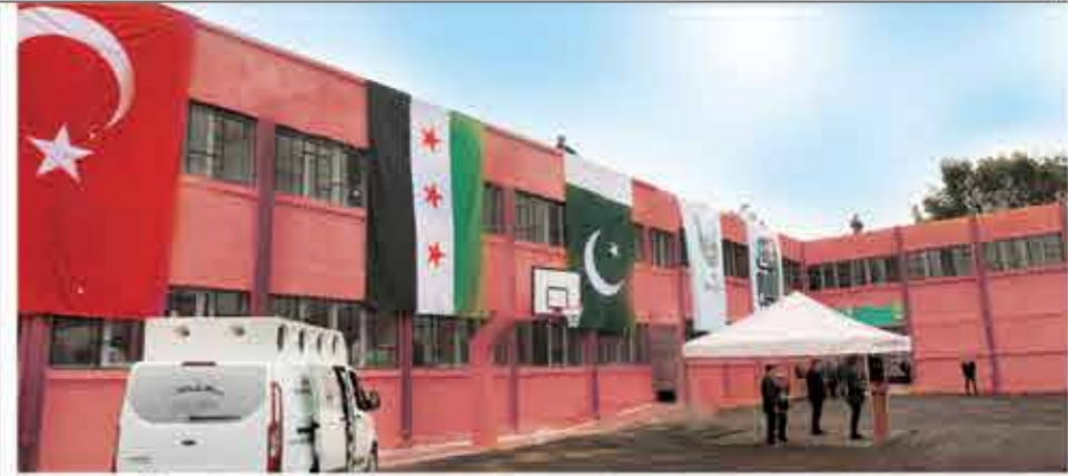
راہ العین میں سالم الماری اسکول۔ یہ اسکول جنگ سے تباہ حال تھا۔ اہل خیر نے بیت السلام کی دعوت پر اس کی تعمیر نو کی۔ چنانچہ 1 لاکھ 3 ہزار ڈالر سے تعمیر نو کے بعد تیار ہے اور یہاں ہر سہ روز سے مڈل تک کے ایک ہزار طلبہ تعلیم حاصل کریں گے
